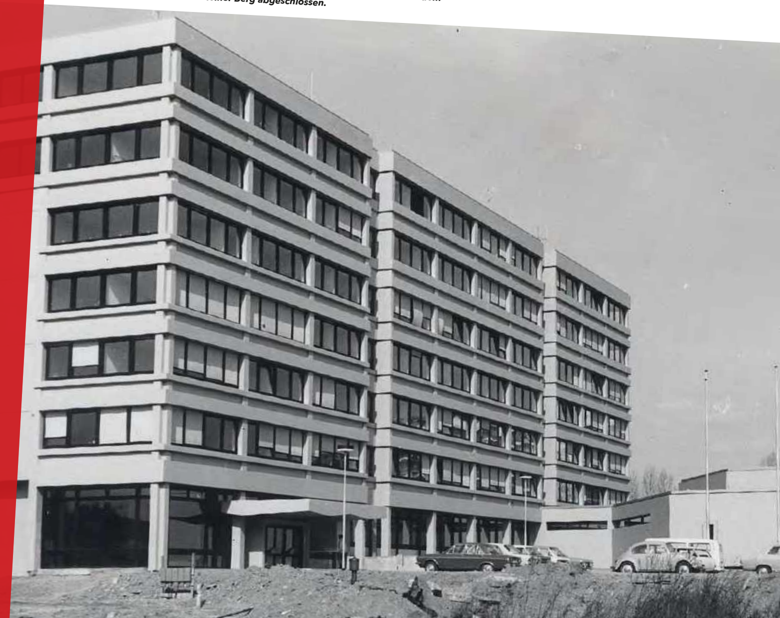
1973 ist der erste Bauabschnitt des HLKA-Neubaus auf dem Schiersteiner Berg abgeschlossen.
