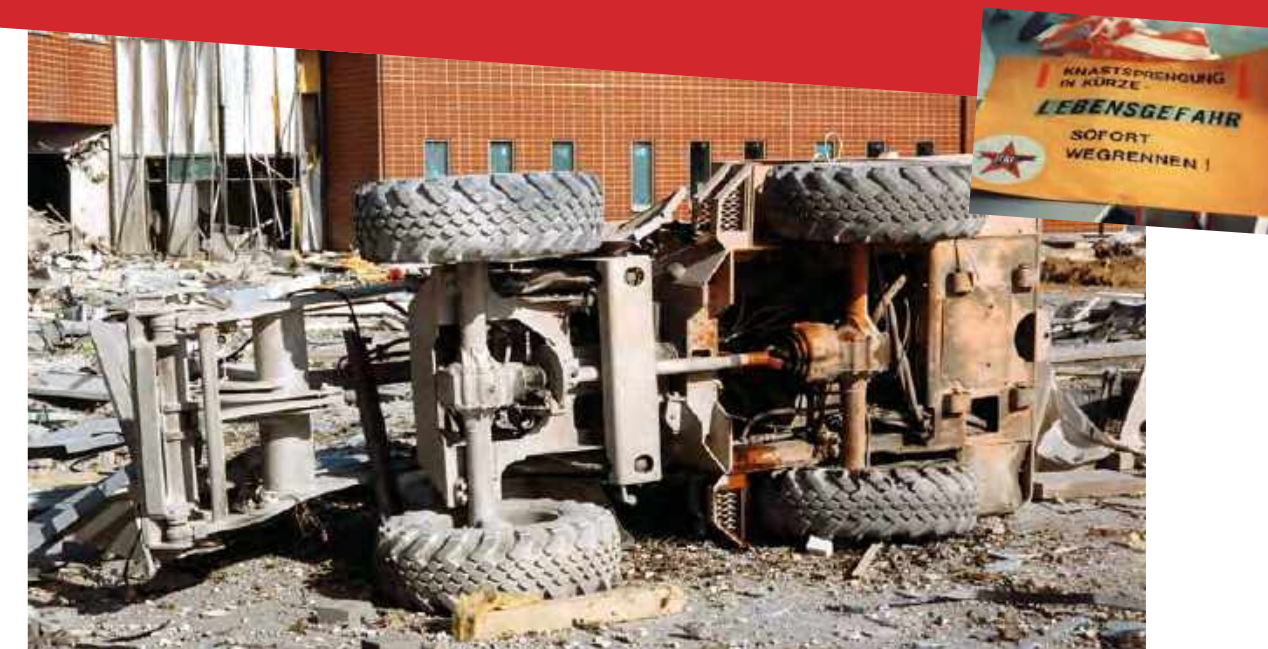
Am 28. März 1993 liegt vor dem schwer beschädigten Verwaltungsgebäude des Gefängnisbaus in Weiterstadt bei Darmstadt ein umgestürztes Baufahrzeug. Am Vortag hatte ein Kommando der RAF einen Sprengstoffanschlag auf die Baustelle von Hessens modernster Justizvollzugsanstalt verübt.
