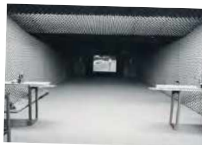
Im Keller des Neubaus ist eine Schießanlage mit Schießkino untergebracht.
