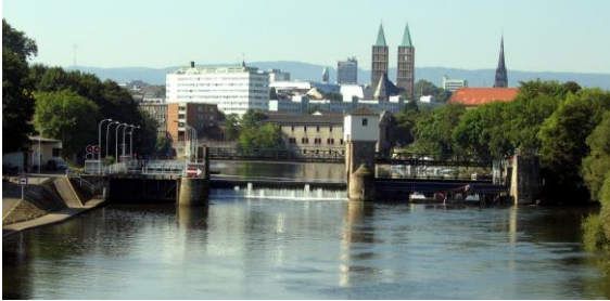
Stadtschleuse Kassel bei Fulda-km 81,270
